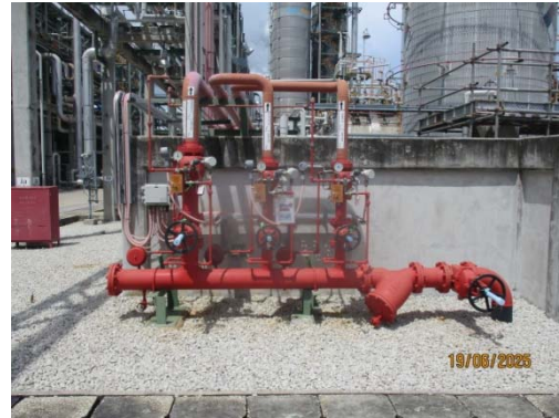
รูปที่ 43 ระบบน้ำดับเพลิงระบบเปิด (Deluge Water Systems)
