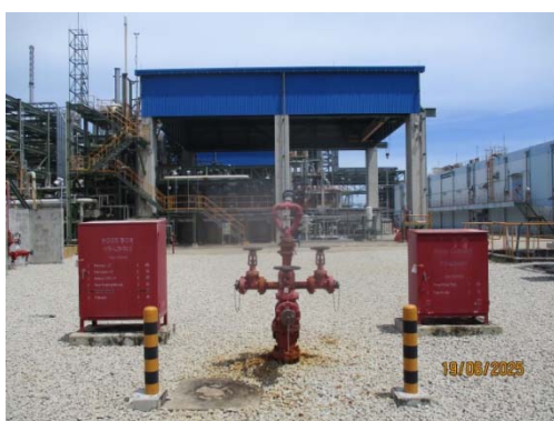
รูปที่ 46 Water Hydrant
