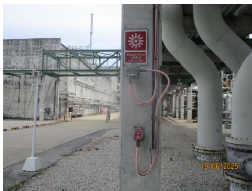
รูปที่ 50 Manual Pull Station
