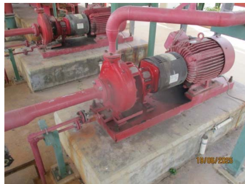
รูปที่ 59 Electric Jockey Pump
