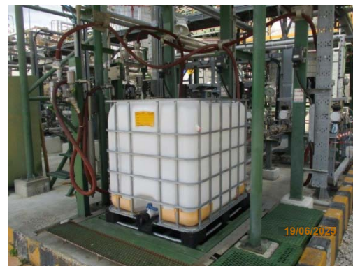
รูปที่ 27 ถังเก็บน้ำมันหล่อลื่น ที่ผ่านการใช้งานแล้วที่มีสภาพผิดปกติ
