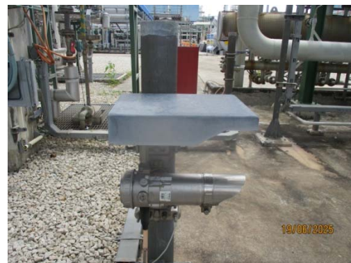
รูปที่ 51 Flame Detector
