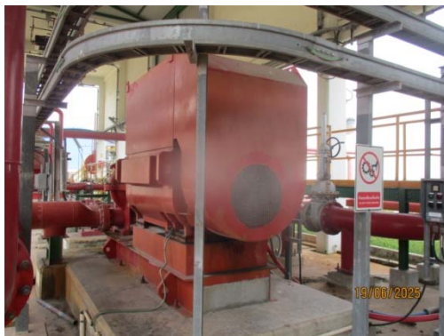
รูปที่ 58 Electric Fire Pump
