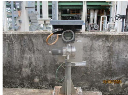
รูปที่ 49 Gas Detector
