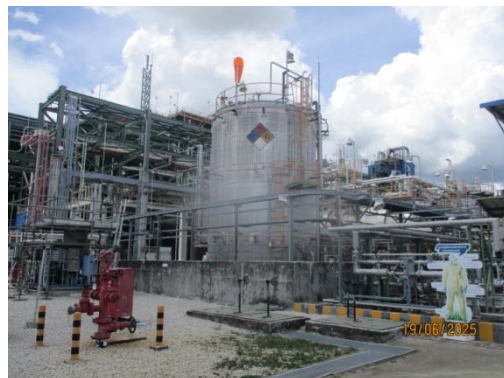
รูปที่ 34 คั่นคอนกรีตรอบถังกักเก็บ Isododecane
