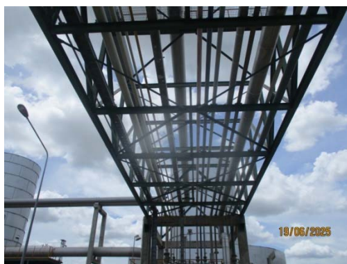
รูปที่ 5 ระบบรวบรวมสารอินทรีย์ระเหย เพื่อนำไปเผาในหอเผาของโรงงานอีเทนแครกเกอร์
