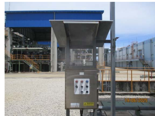
รูปที่ 45 Water Monitor Remote
