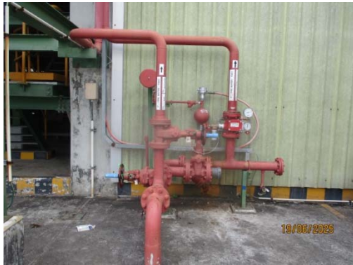
รูปที่ 42 Wet Alarm System
