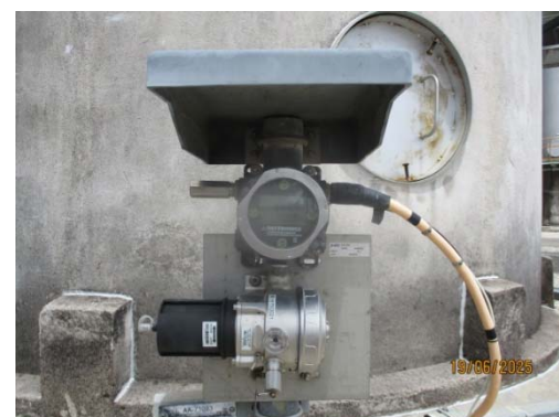
รูปที่ 35 Gas Detector บริเวณถัง Isododecane และ Propionic Aldehyde
