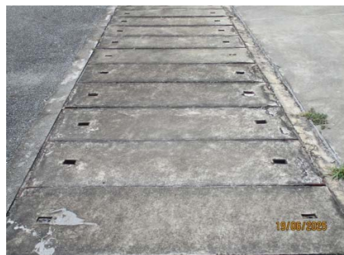
รูปที่ 18 รางระบายน้ำฝนในพื้นที่โรงงาน
